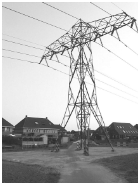
De hoogspanningskabels tussen de Eckhartstraat en de Magnusstraat.
